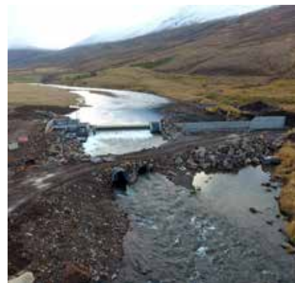
Búið að steypa allt.
