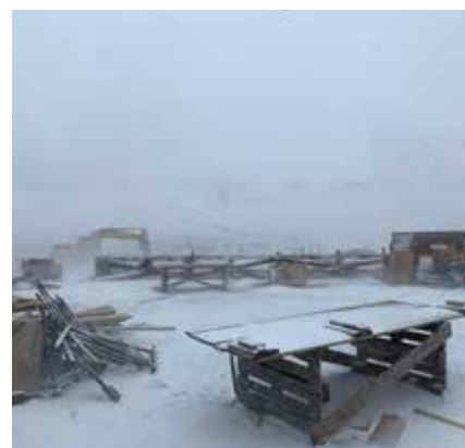
Það var unnið í öllu veðri.
