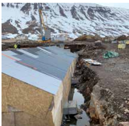
Byggt yfir byggingarsvæðið.
