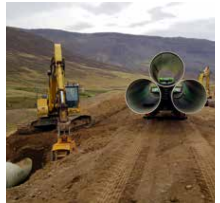
Rör flutt til.
