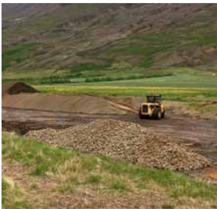
Hér er unnið efni til að setja í kringum rörin.
